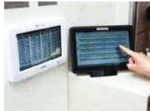
空調設備運用と電力使用状況を一括監視し効率化を支援。タブレット端末による省スペース化、スムーズな操作性を実現している。
